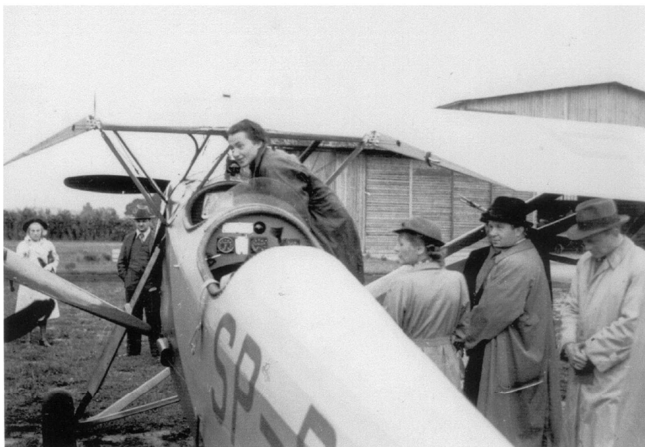
Barbara Wojtulanis zagląda do kabiny RWD-8 produkcji DWL. Widoczna tylna tablica przyrządów i stała przegródka między kabinami (w wersji PWS była ona demontowalna, a tablice przyrządów nie było).
