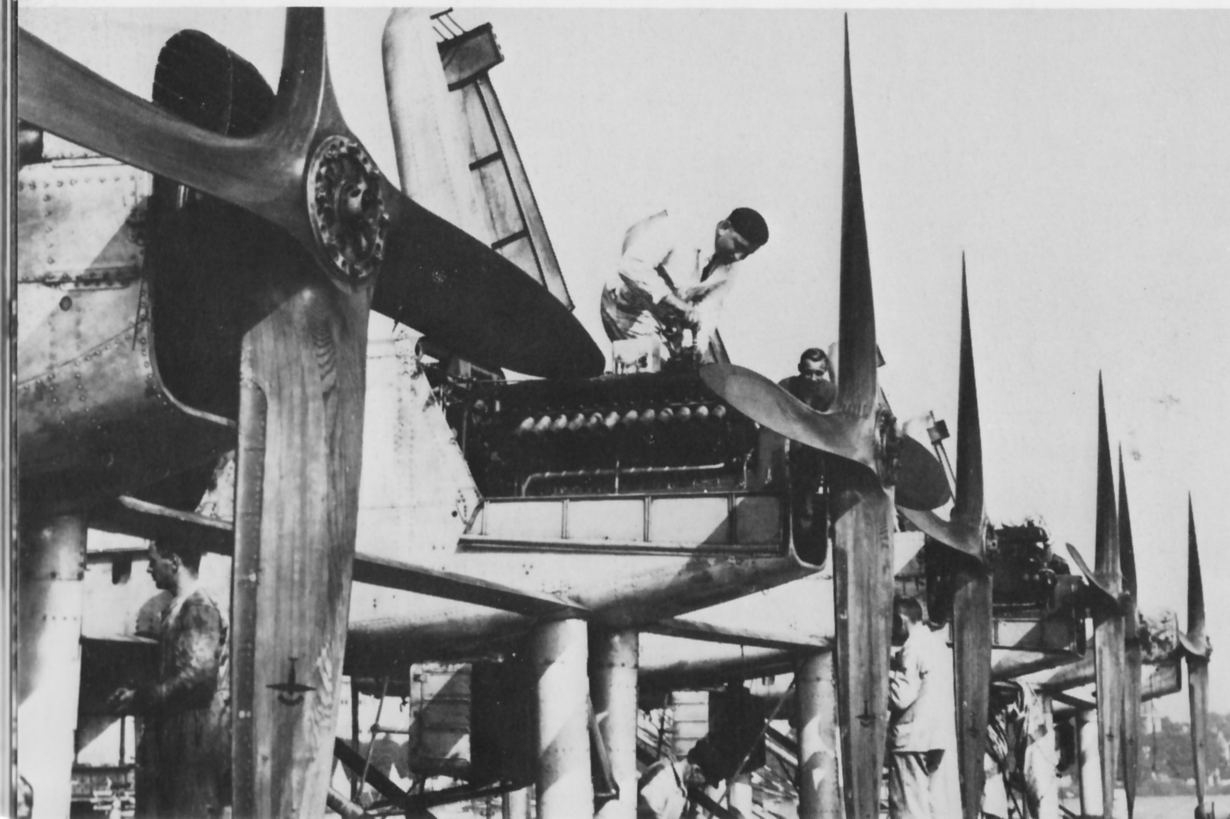
Motorenüberholung. Engine overhaul
