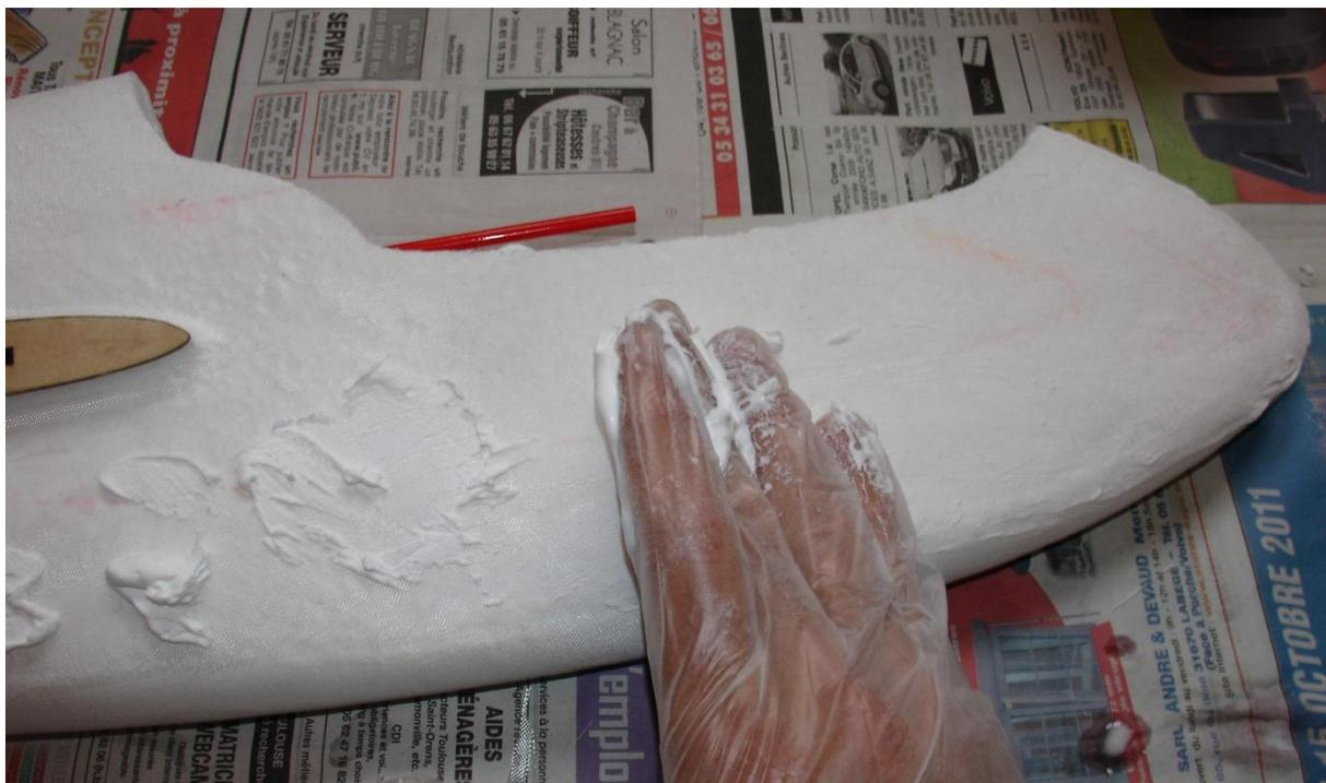
Une fois sec, poncer l'enduit au papier de verre grain 120 en évitant de traverser la fibre.
